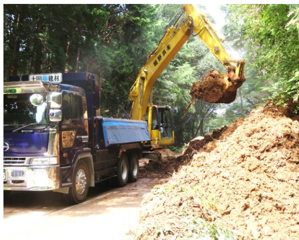
電線処理され、土砂運び出し
