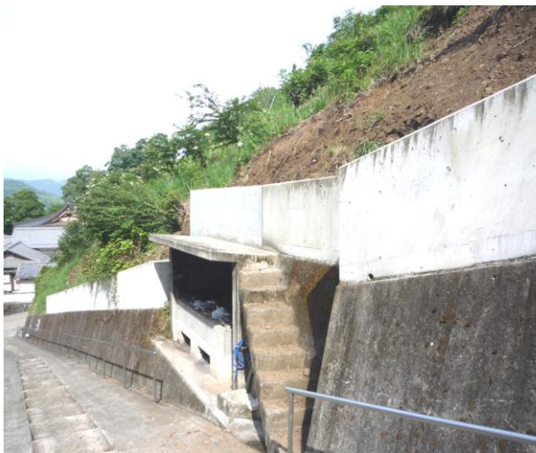
第一墓地 崩落後、壁を増設
