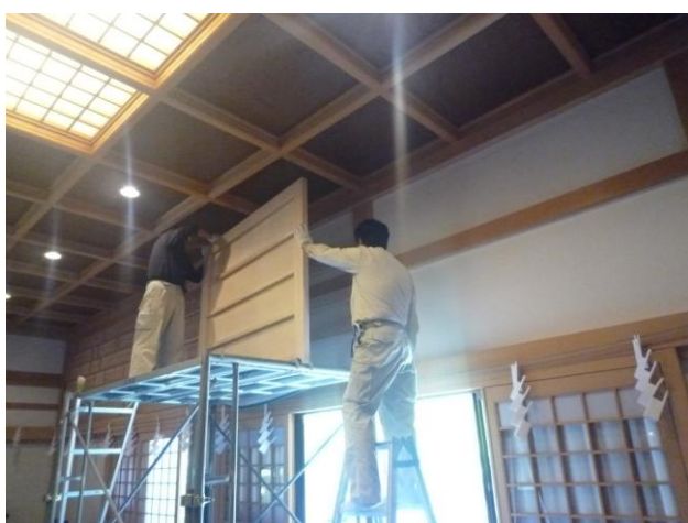
奉納額 足場を組んで取り付け
