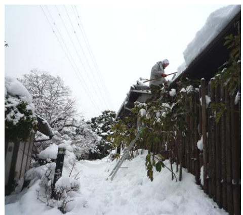
ベランダが雪の重さでたわみ急いで屋根に登って雪おろし
