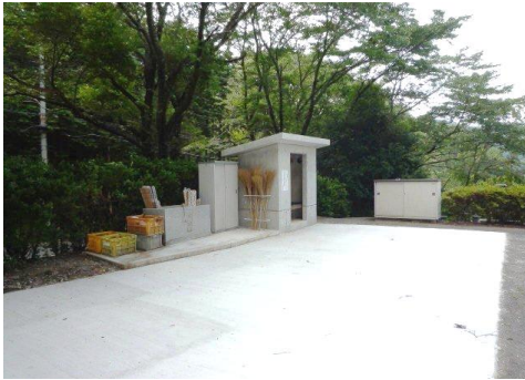
右 第1墓地 壁工事 左 第2墓地 駐車場舗装、焼却炉
